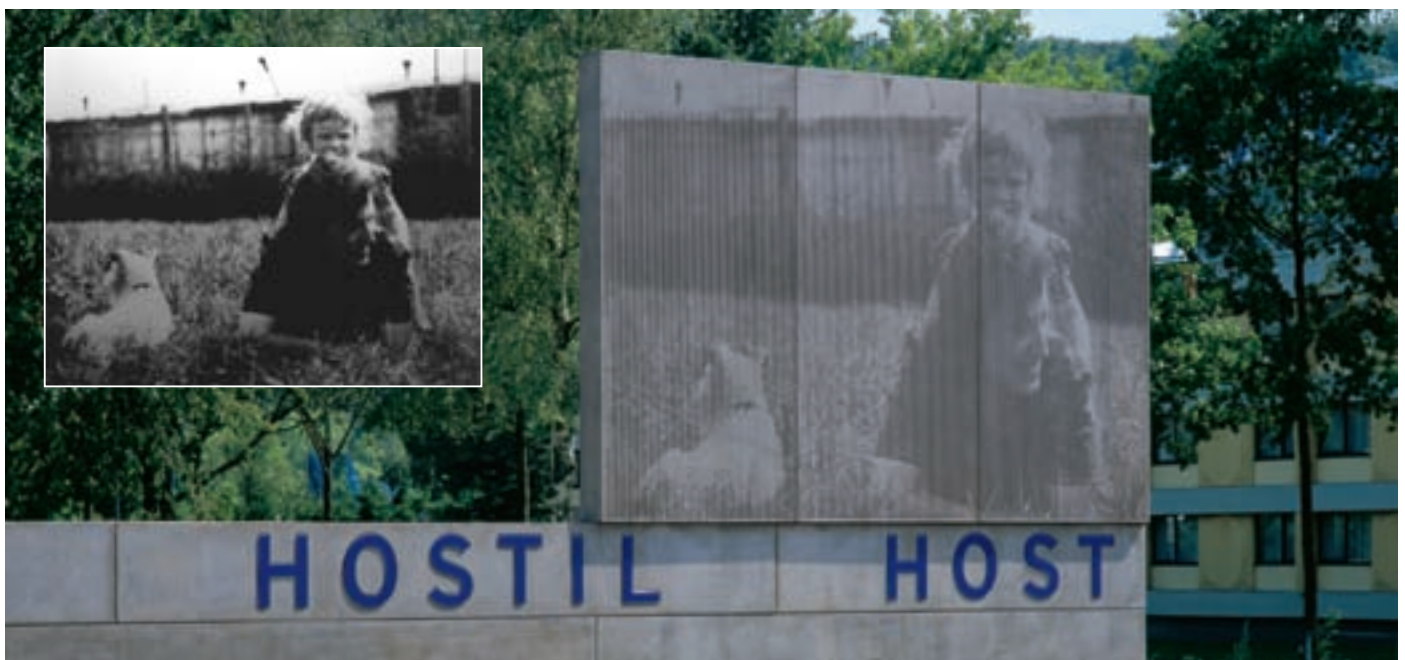
Originalbildvorlage und Betonelement, RECKLI® Foto-Gravur-Matrize, Gedenkstätte „Neue Bremm“, Saarbrücken, Architekten Poppensieker & Schulze Icking, Berlin Image template and concrete element, RECKLI® Photo-Engraving Formliner, memorial „Neue Bremm“, Saarbrücken, architects Poppensieker & Schulze Icking, Berlin Image originale et élément béton, matrice RECKLI® Photo-Gravure, lieu commémoratif „Neue Bremm“, Saarbrück, architectes Poppensieker & Schulze Icking, Berlin
